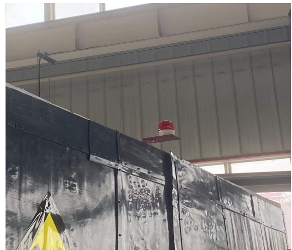
照片 4 声光报警装置
