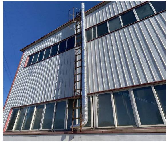
照片 9 排风口及外部排风管道
