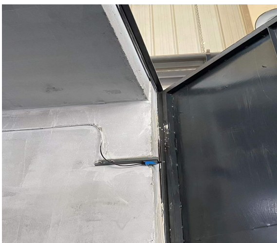
照片 5 防护门门机联锁装置
