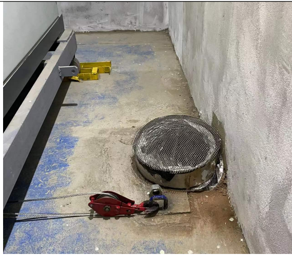
照片 9 排风口及外部排风管道
