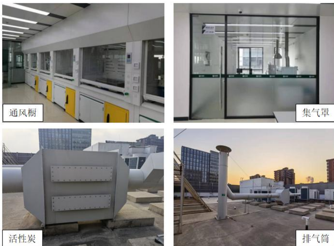
图 4-3 废气收集及处理系统
