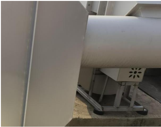
图 4-4 基础减震措施
